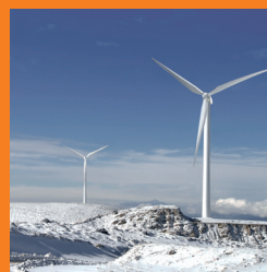
魏德米勒监控系统
