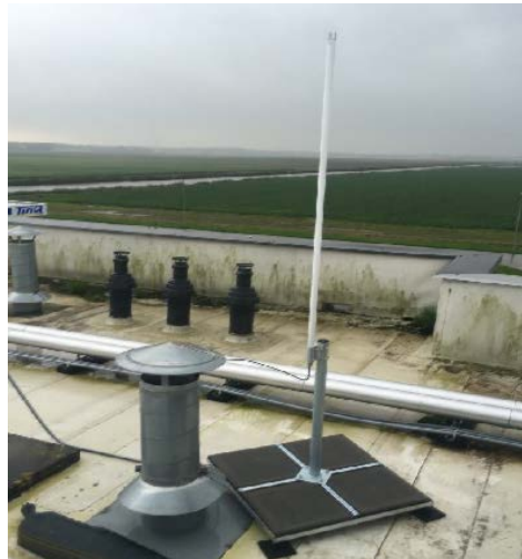
Figura 41. Ejemplo de colocación de la antena del Gateway LoRaWAN® en un tejado
