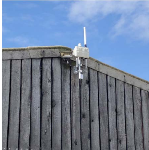
Figura 42. Ejemplo de colocación de la antena Gateway LoRaWAN® en una pared lateral de un edificio
