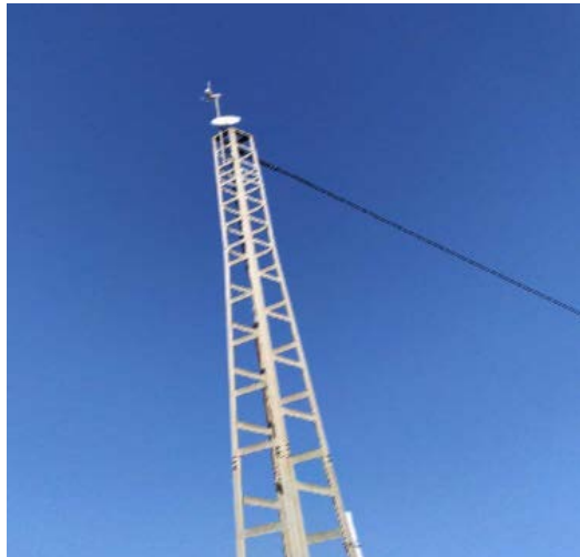
Figura 40. Ejemplo de colocación de la antena del Gateway LoRaWAN® en una torre
