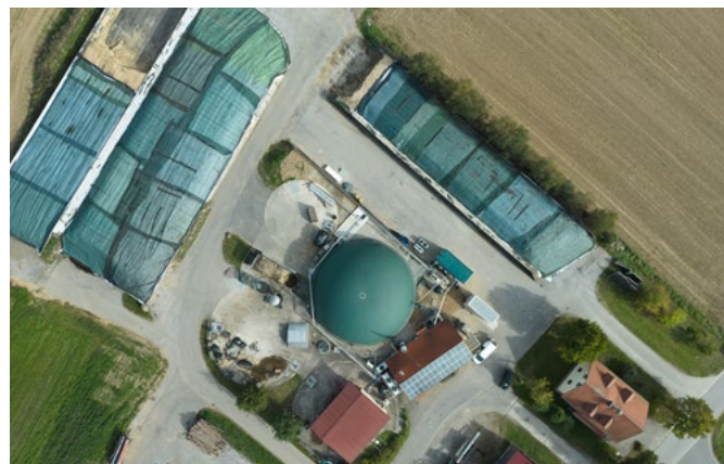
In den grünen Containern von Reverion wird Elektrizität in Speichergas umgewandelt – und umgekehrt. Bildquelle: Reverion GmbH, Fabian Vogl
