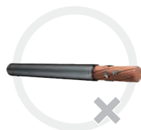
Maradék szigetelés darabok a vezetőn
