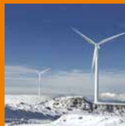
魏德米勒监控系统
