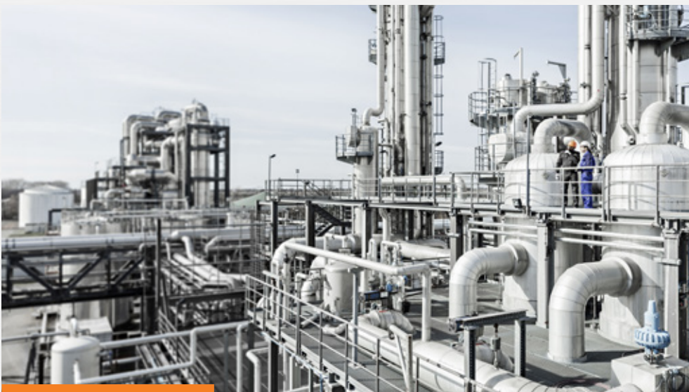
Eigensichere Prozessindustrie mit Ethernet-APL
