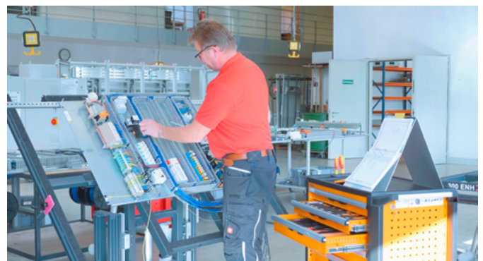
In modernen Fertigungsstätten setzt Bosch Building Automation GmbH auch bei der Wahl des Überspannungsschutzes auf exzellente Qualität mit dem VARITECTOR AC-Programm von Weidmüller.
