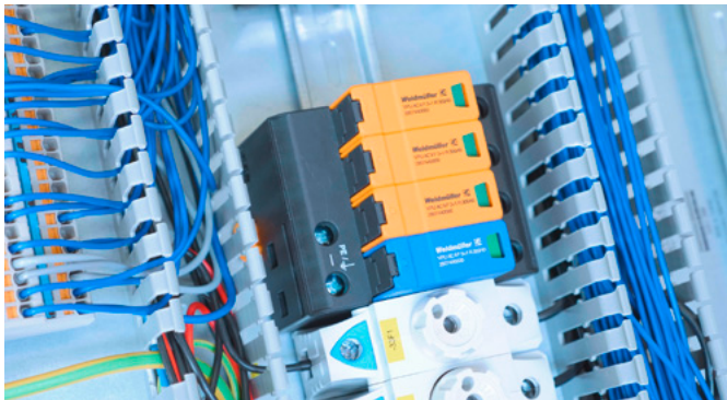
Die kombinierten VARITECTOR AC Typ II+III-Überspannungsschutzgeräte verfügen über eine Vorsicherung je Schutzpfad und sind universell in Energieverteilungen einsetzbar.
